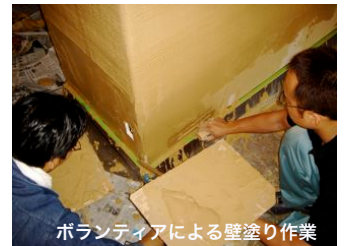
ボランティアによる壁塗り作業
